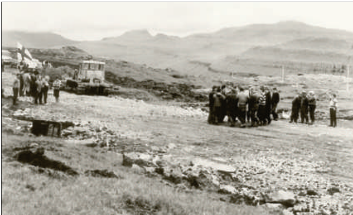
Merkið varð vundið á stong og arbeiðsmenninir sláa ring, tá Oyggjarvegurin bleiv samanbundin 6. juli 1966
