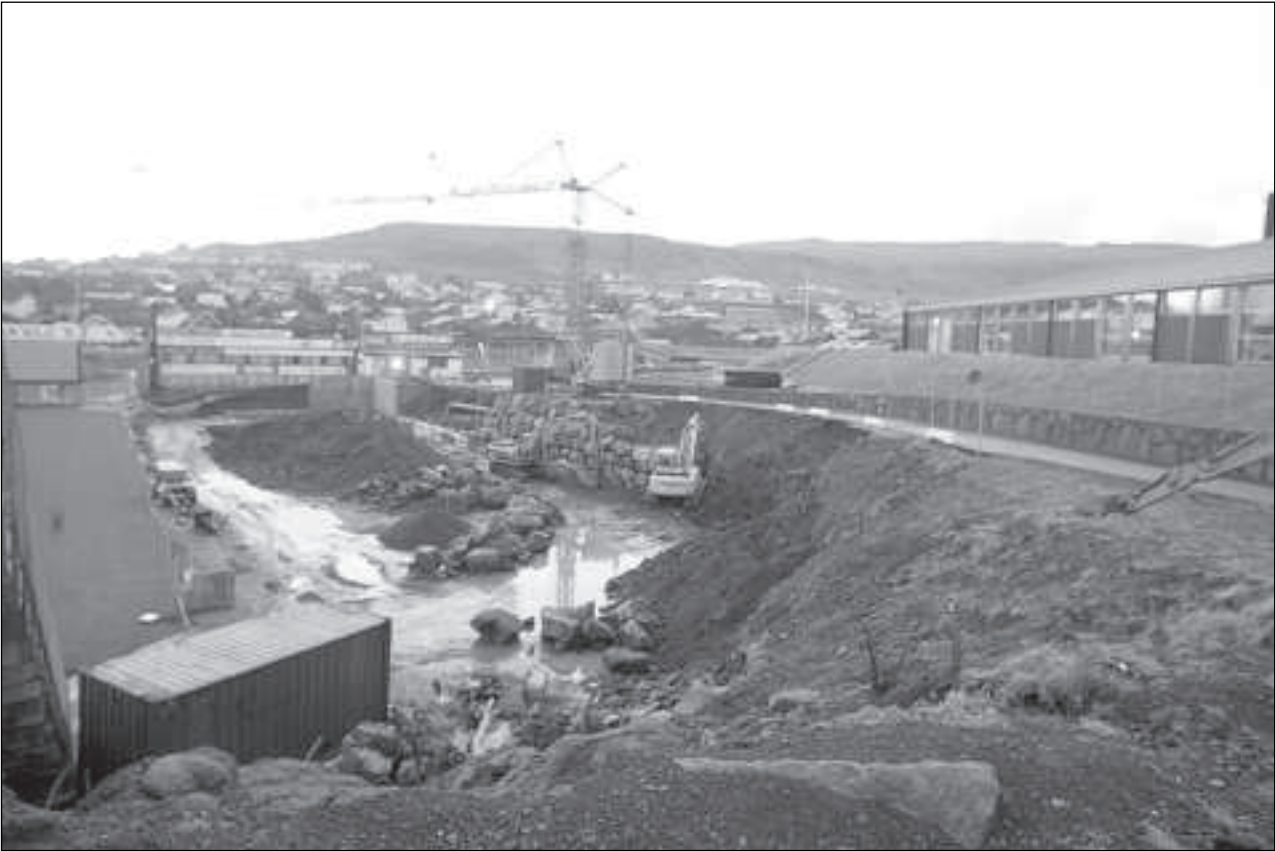
Eftir at MT Højgaard nýtti seinastu mánaðirnar av 2008 at etablera arbeiðs-plássíð, hevur verið arbeitt støðugt síðani nýggja árið byrjaði
