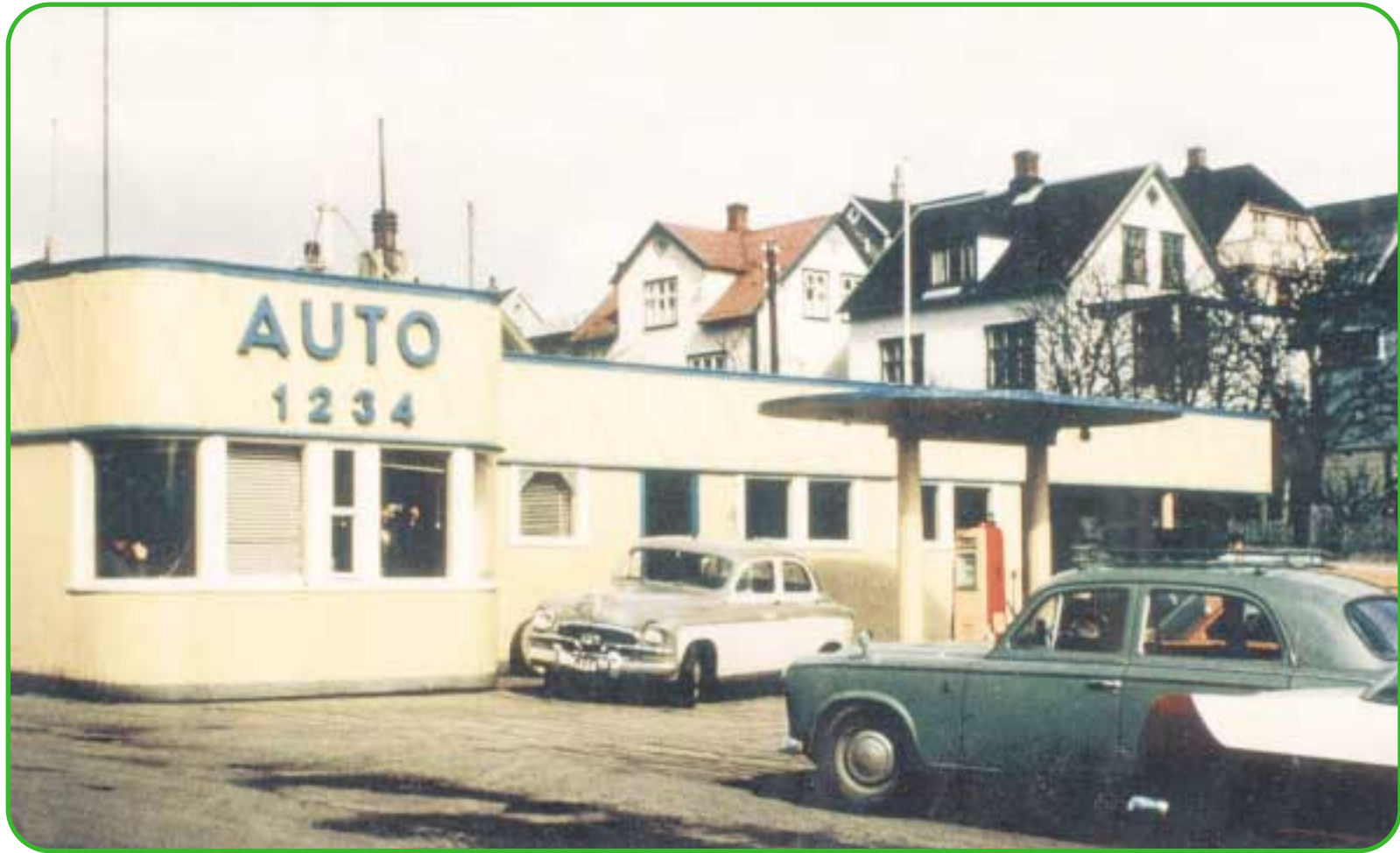
Auto 1234. Petur í Gong, byggimeistari, stød fyrri byggingini av støðini, ið varð liðug í 1956. Árið eftir góvu Napoleon Smith og Olaf Hansen tilboð uppá at mála støðina. H.C.W. Tórgarð, arkitekt, teknaði støðina, sum var gjørd í samstarvi við P/F Shell. Bilurin inni við støðina, ein Fiat 124 hjá Eigil Gunnarsson, var ein av fyrstu Fiat bilunum í Føroyum. Síðan er ein grønur Peugeot 403 hjá Børge Andreasen, og ein hvítur og reyður Ford Consul hjá Jákup Berg
