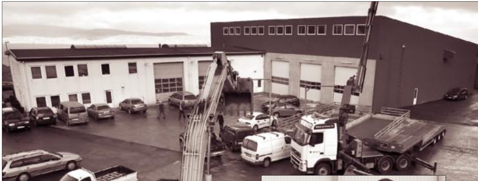
Nýggi bygningurin er bygdur afturat gamla bygninginum hjá MVH
