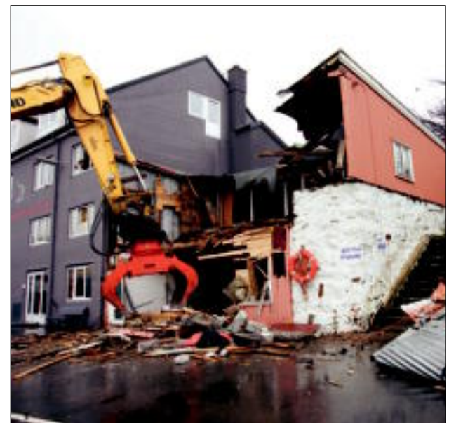
Í morgun var farið undir at bróta sunnara partin av bygninginum hjá Føroya Fiskimannafelag á Bursatanga niður. Bygningurin skal nú byggjast upp aftur í fyra hæddum
