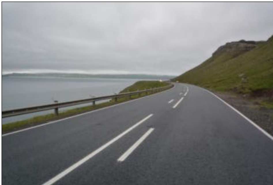
Miðstípurar eru nú málaðar, og rumlistrípurar koma fyrsta dagin (mynd: Landsverk)
