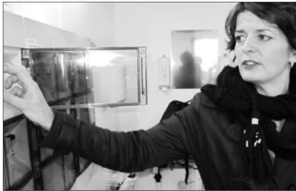
Marin Katrina Frýdal setir her alment pumpuskipanina í gongd. Hetta er fyrsta pumpuskipan í Føroyum, har pumpurnar ikki standa niðri í brunnunum, og viðlíkahald kann gerast lættliga og reinligt
