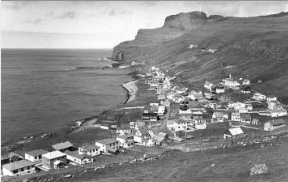
Hesi seinastu 40 áriní eru í støðum 17 metrar mataðir burturav Bakkanum í Sumba. Tí er tað alneyðugt at okkurt verður gjørt fyri at tryggja bygdina ímóti at skola á sjógv
