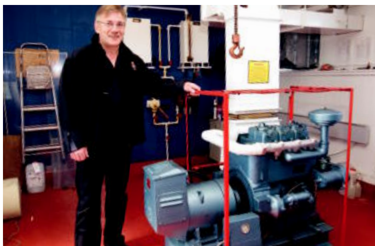
Hans Petur Kjærbo er ein av teimum fimm fyrpassarunum, ið starvast hjá Danska Farvandsvæsenet. Hesir hava til uppgávu at røkja og halda við líka 27 vitar og tilhoyrandi hús, sum hoyra til nakrar av vitunum
