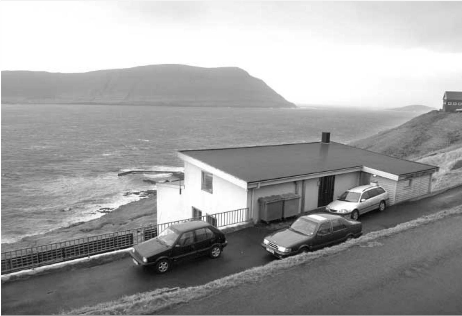
Í vakra umhvørvinum á Velbastað húsast Heilbrigdið, sum nú hevur verið virkið í 15 ár.
