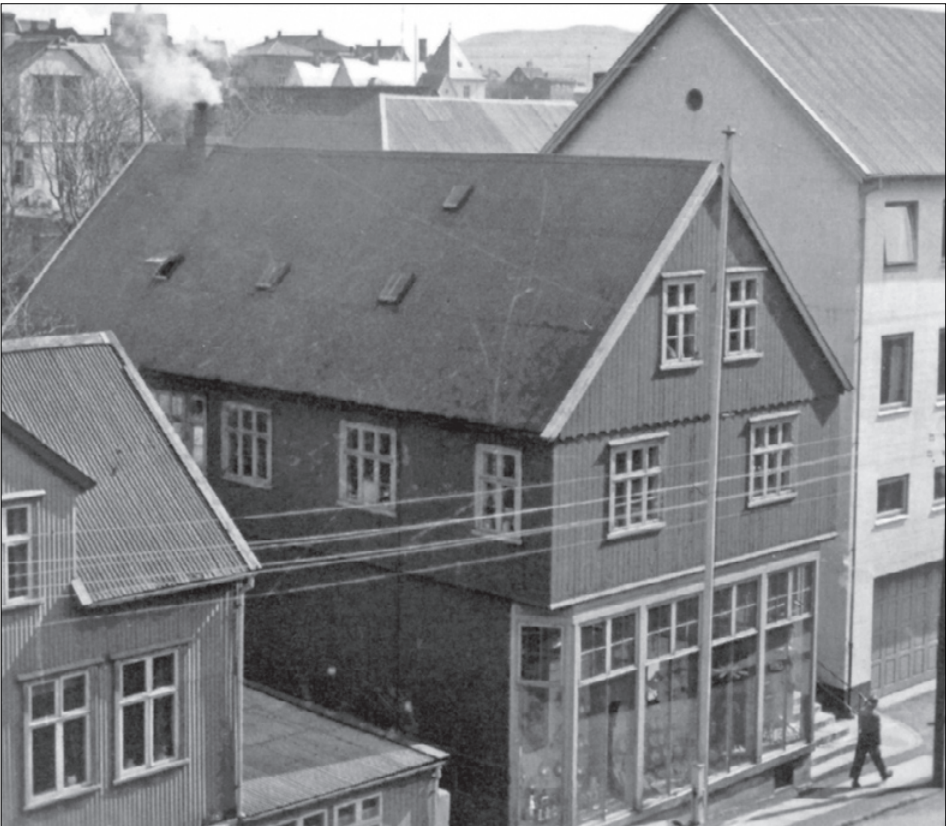
Í 1946 byrjar Thomas Dam at handla í Niels Finsensgøtu og Steingrim fer at arbeiða hjá honum Mynd: Magna Restorff
