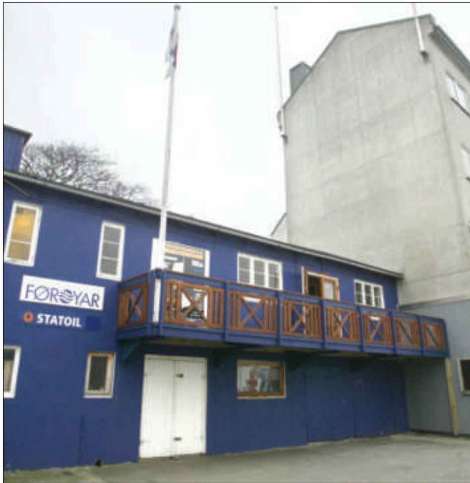
Verandi bygningur hjá Tórshavnar Bátafelag undir Bryggjubakka skal rívast niður og nýggjur bygningur í fyra hæddum byggjast í staðin
