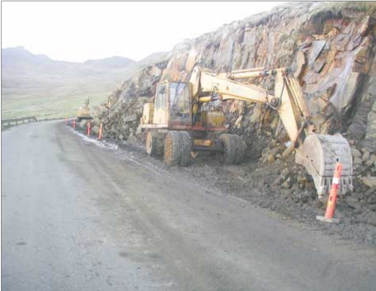
Maskinurnar hava nú staðið stillar í einar tríggar vikur og sostatt er arbeiðið at bota upp á ein tann vandamesta landsvegin í landinum, steðgað. Ósemja er um grótið, sum verður sprongt burtur
