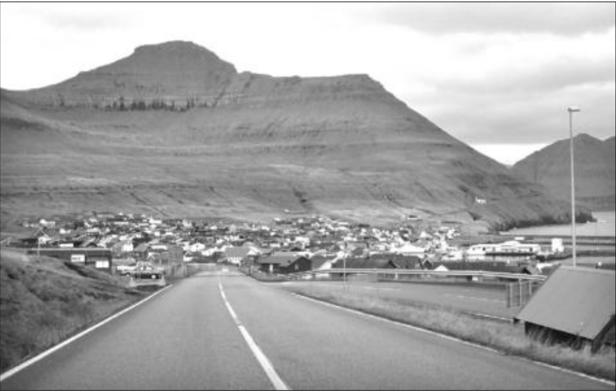
Enn er løgreglan ikki komin til nakra niðurstøðu um hon fer at leggja uppí, ger býráðið í Eysturkommunu álvara av at stongja vegin í sambandi við Norðoyatunnilin
