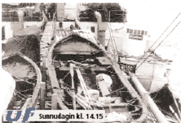
Føroyingar fóru í fíatúrarnar í Føroyingahavnina við »Etruveldi«, sum fórð smáubátar fyri útróðarmenn. Jóhann Petersen í Norð-depli var ein
