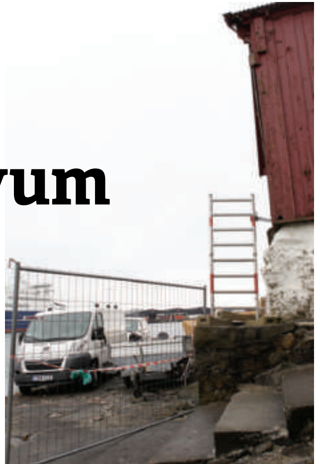
Tinganes er stongt av, meðan arbeiðt verður við at klæða og leggja nýtt tak á húsini
