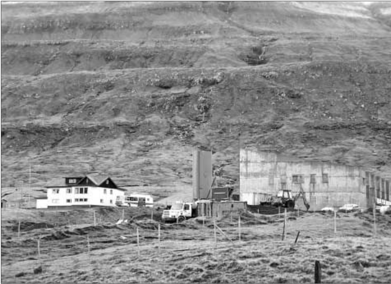
Nýggi bygningurin hjá Kelduni er innan fyri verandi samkomuhúsið, sum er vorðið ov lítið til virksemið hjá samkomuni
