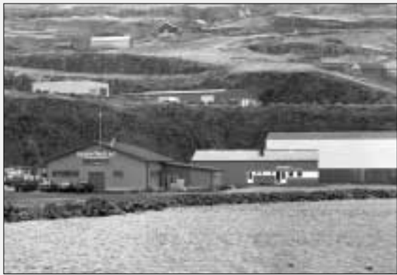
Hydro-Tech fer at flyta úr smiðjubygninginum fremst á myndini í stóra bygningin longst burtur
