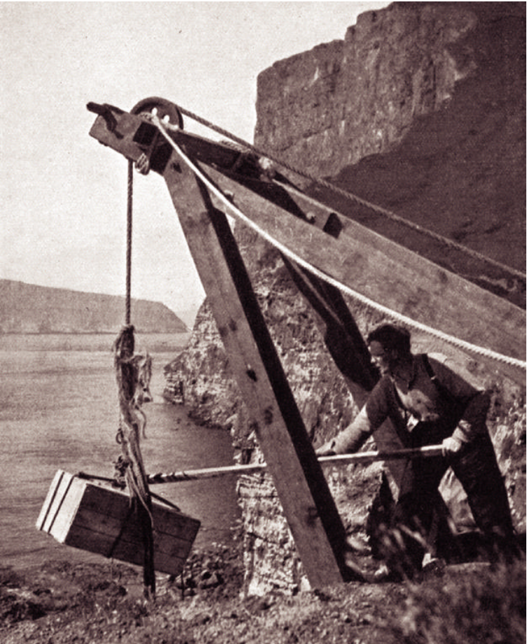
Drátturin í Stóru Dímun. Hetta var kranin, sum varð nýttur at fáa vøru upp á oynna. Fyrstu árin var hálað við mannamegi. Tey seinnu vórðu ross brúkt
