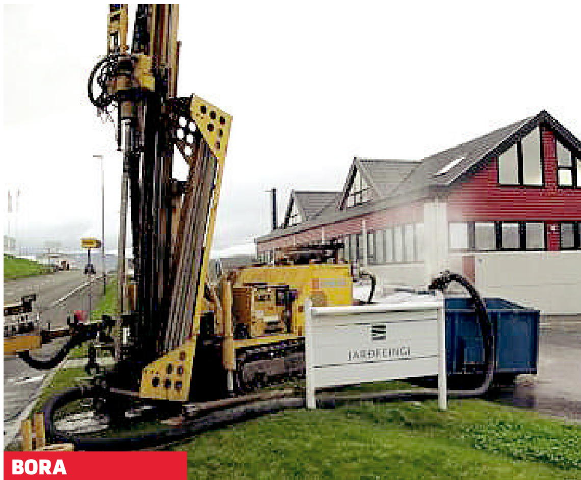
Jarðhitaboring uttanfyri skrivstovuna hjá Jarðfeingi í Hoyvík
