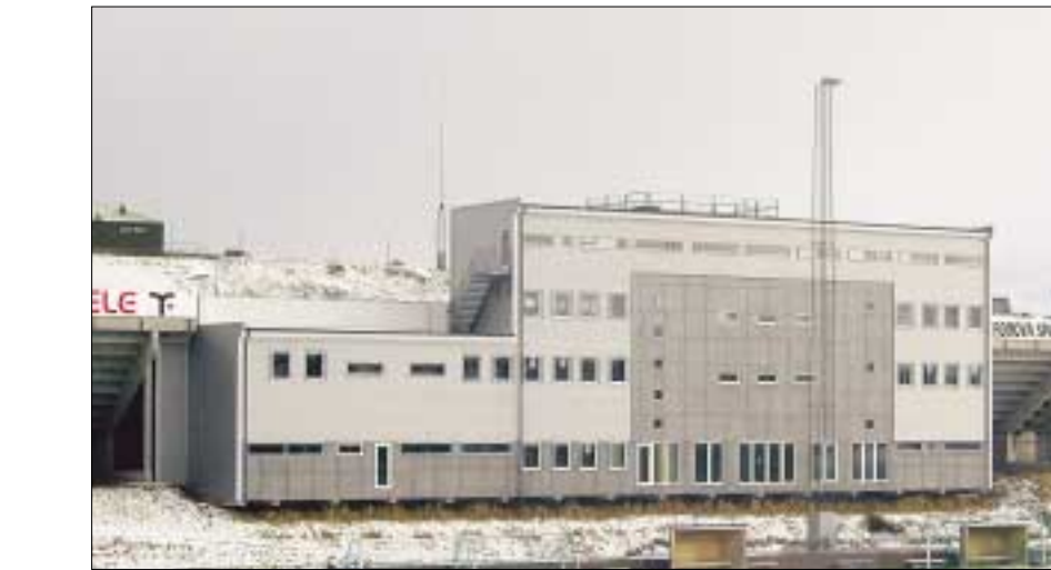
Aðalfundurin hjá FSF tók avgerð um, at bygningurin við Tórsvøll skal yvirtakast, men hóast eingin atkvøddi ímóti hesum, so vóru atfanningarnar nógvar
