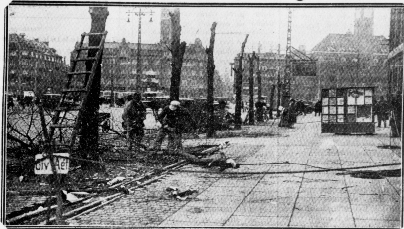
Umvølingararbeið í gøtunum.
