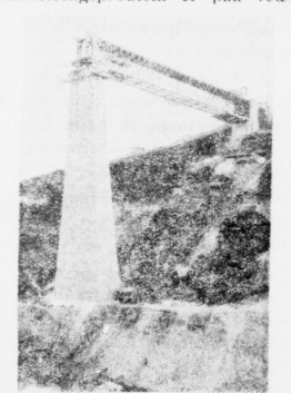
Et Yderlag af Fadesbroen er monteret færdigt.
